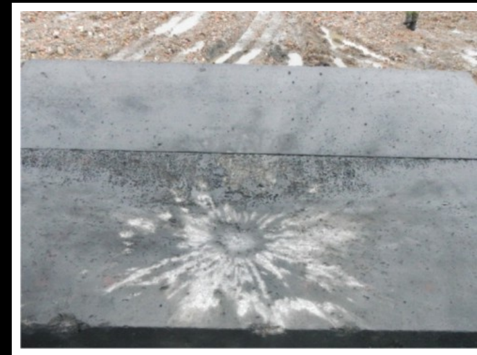
Po zkoušce UHPC desky
